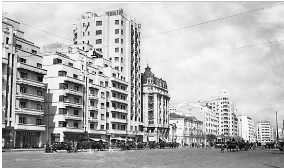
Fig.1.31 Blocul Carlton inainte de cutremur
