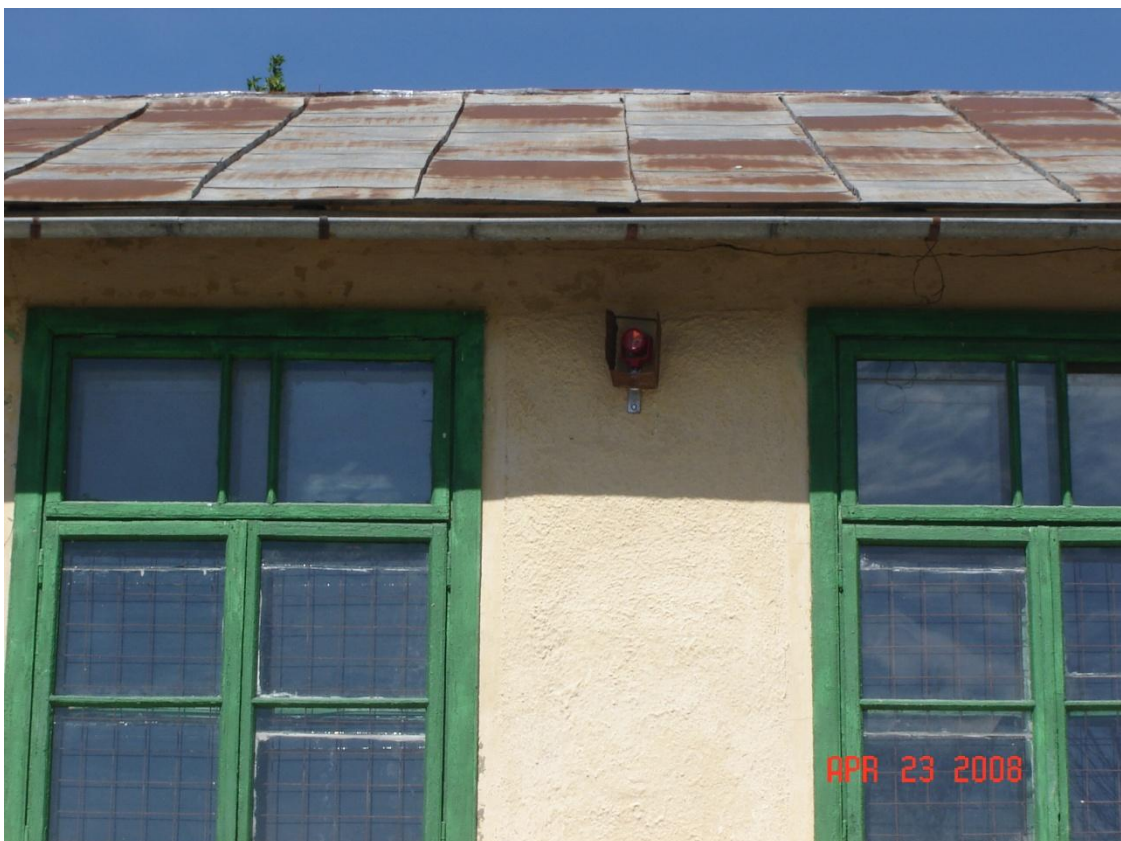
Fig. 3.2.6. Amplasarea reflectorului laser pe peretele școlii
