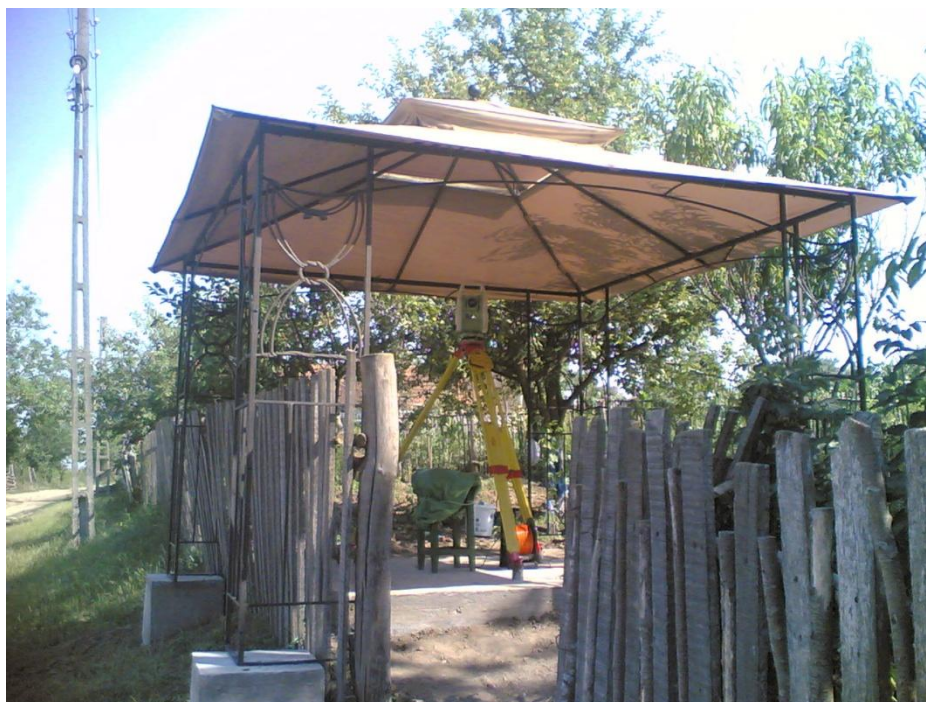
Fig. 3.2.8 Adăpostirea stației Leica TC 1201 sub pavilion
